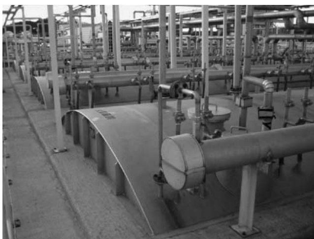
写真-1 嫌気排水処理設備（リアクタ）
