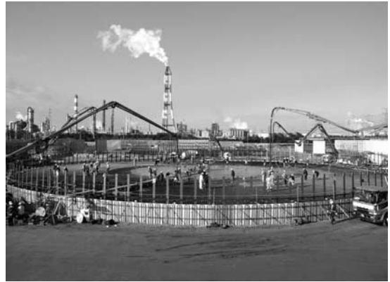
写真-5 低温タンク基礎コンクリート打設状況
