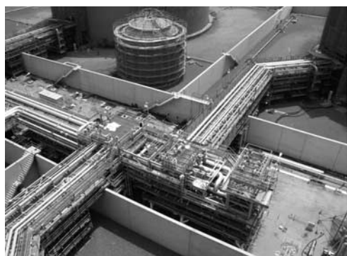
写真—6 配管工事の施工状況
