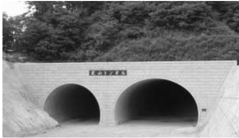
写真一4 坑門工完成後
