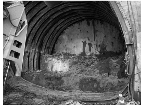
写真一6 識名トンネル掘削状況(補助ベンチ付き全断面掘削+早期閉合)
