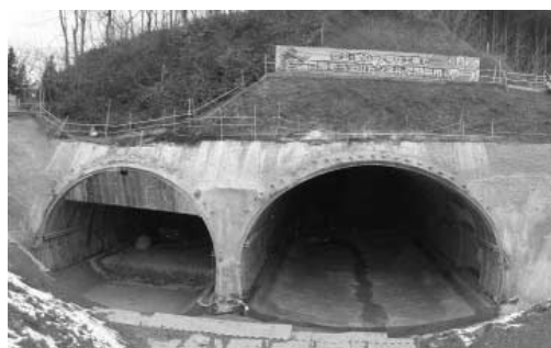
写真—3 北山トンネル坑口部
