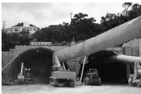
写真一5 識名トンネル坑口部
