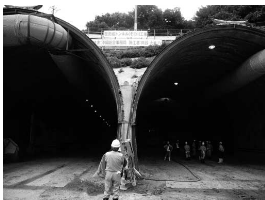
写真—1 豊見城トンネル坑口部
