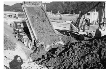
写真十四 現場 3 日強度 コーン指数確認状況
