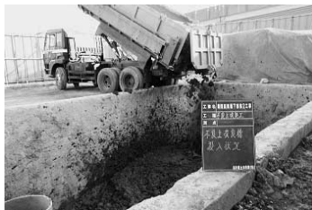
写真四 不良土改良槽投入状況
