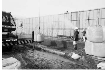
写真八 固化剤マデックス投入状況
