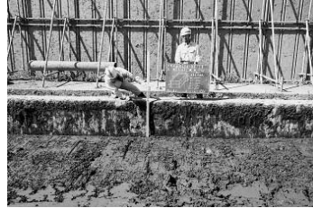
写真十 改良土土量確認状況
