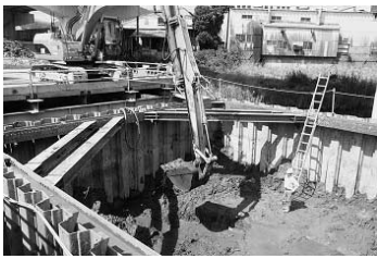
写真二 不良土掘削状況
