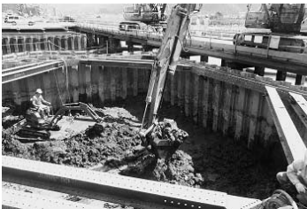
写真二 不良土掘削状況
