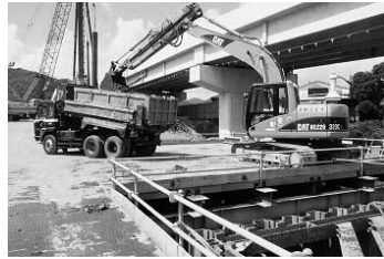
写真三 不良土積込状況
