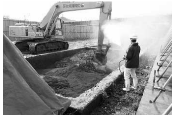
写真九 バックホー攪拌状況
