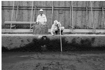
写真五 不良土土量確認状況
