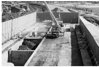
写真七 固化剤マデックス投入状況
