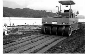
写真十五 転圧状況
