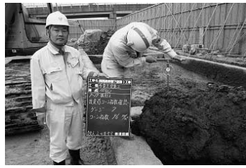
写真六 不良土コーン指数確認状況
