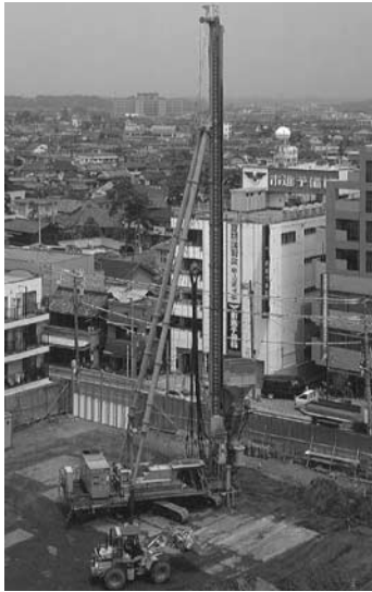
写真一 市街地での施工状況
