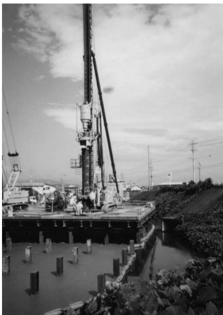
写真-3 施工例 1 構台施工状況
