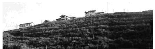
写真—3 宮崎県 霧島台地における適用事例。アルファグリーン工法にて約2万m<sup>2</sup>を施工した。木本類を中心に生育している。1999年4月施工
