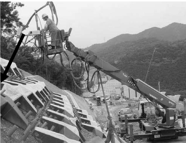
写真一17 高所作業車専用吹付ノズルアタッチメント
