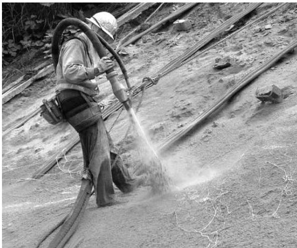
写真—6 長繊維混入補強土吹付状況
