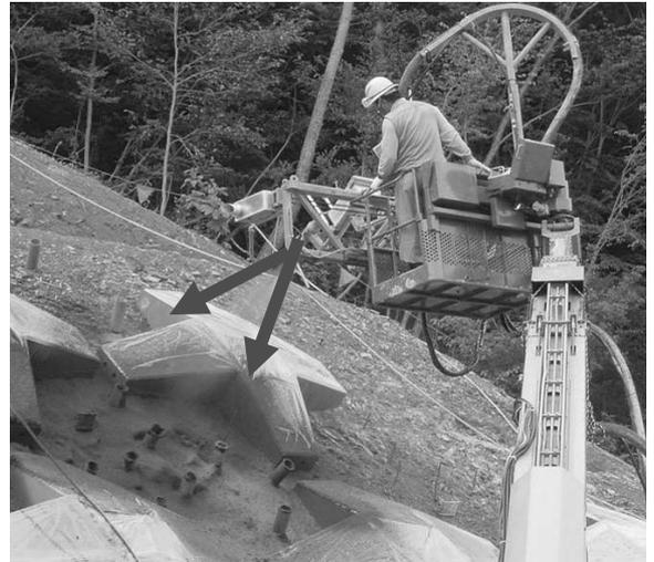
写真一18 高所作業車専用吹付ノズルアタッチメント近景
