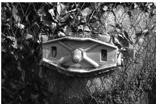
写真—1 高強度ネット、クモ用プレート、補強材頭部ネット、ざぶとん材
