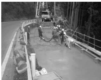
保護コンクリート工
