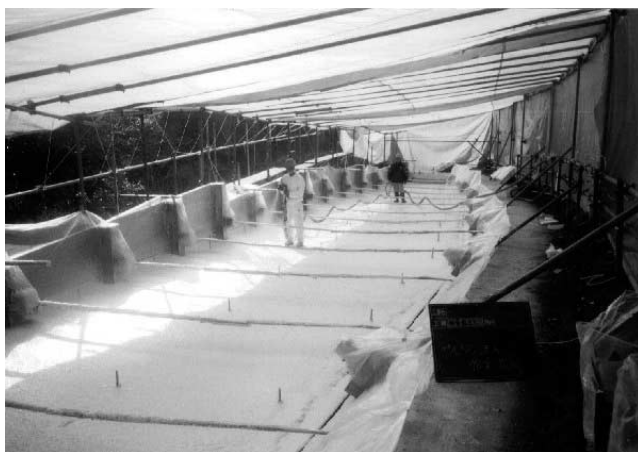
写真—1 施工状況
