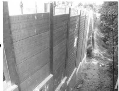
壁面材設置工
