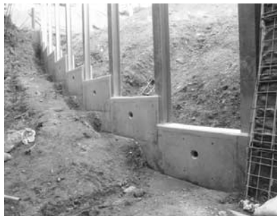
調整コンクリート工
