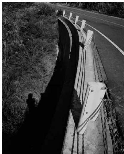
写真—4 国道 290 号 R-PUR 工法現況
