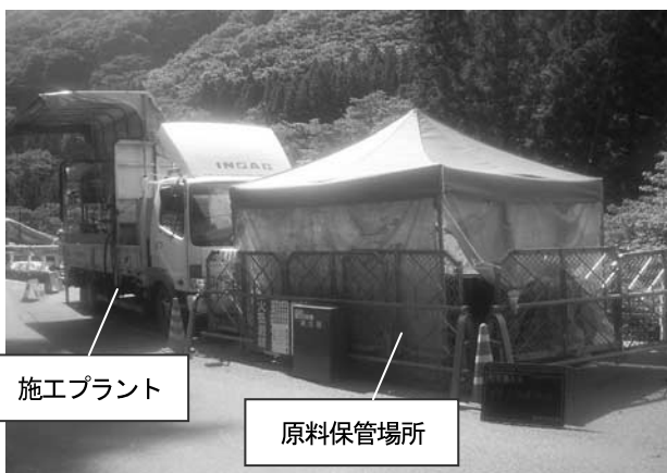
写真-2 施工ヤード設置状況
