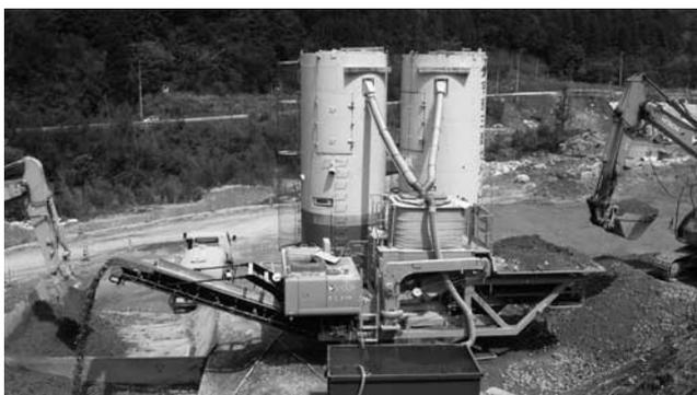
写真一 4 自走式土質改良機による CSG 製造
