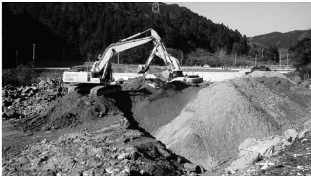
写真一 3 スケルトンバックホウによる母材採取
