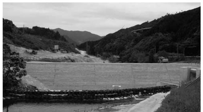
写真一 8 CSG 仮締切堤完成写真
