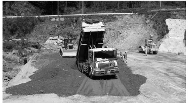
写真一 5 製造された CSG の運搬・荷降ろし
