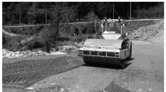
写真一 6 10t 振動ローラによる CSG 転圧
