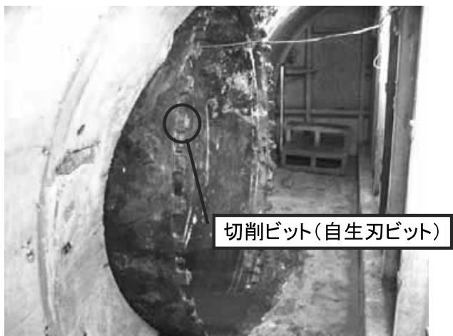
写真-1 T-BOSS工法到達接合状況
