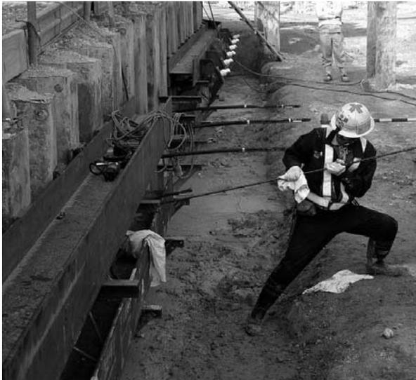
写真一五 人力による引抜き状況
