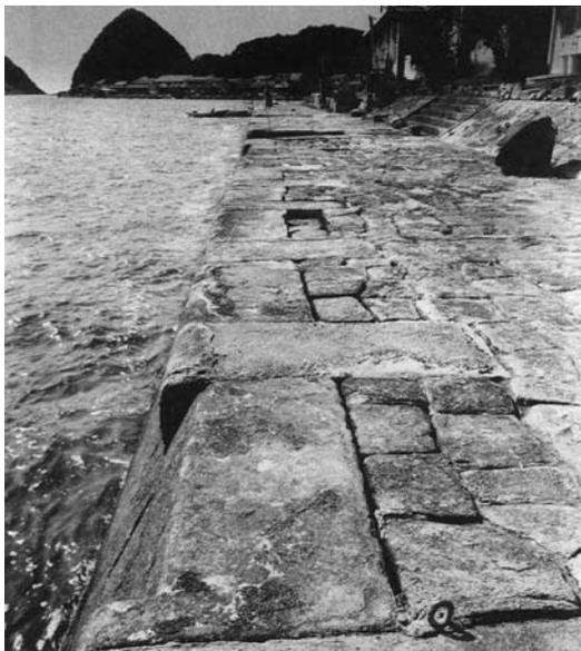
写真—1 修復前の破損した石積埠頭
