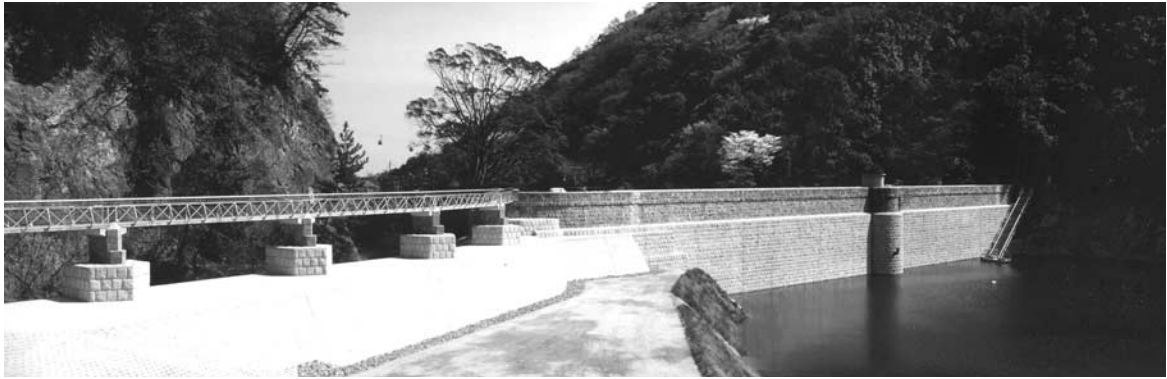
写真—5 管理橋・堤体補強完了全景
