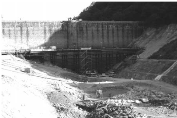
写真-2 バンカー線(作業用構台)全景
