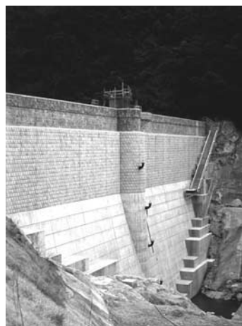
写真-3 堤体補強完了全景
