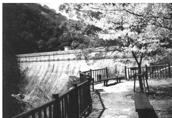
写真-1 下流側よりの布引ダム全景
