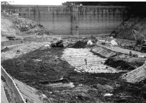
写真—4 軟弱土固化処理状況
