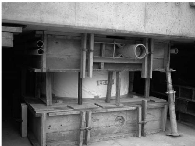
写真—10 免震部材・基礎設置
