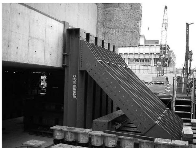
写真-9 水平補強状況
