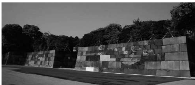
写真—1 中之門石垣の修復工事完了後の全景
