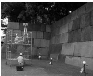
写真—3 Dレーザースキャナでの石垣表面の計測作業
