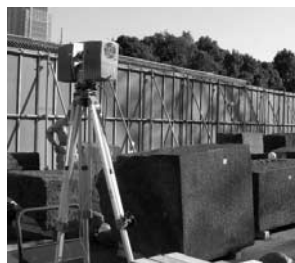
写真—4 石材の計測作業
