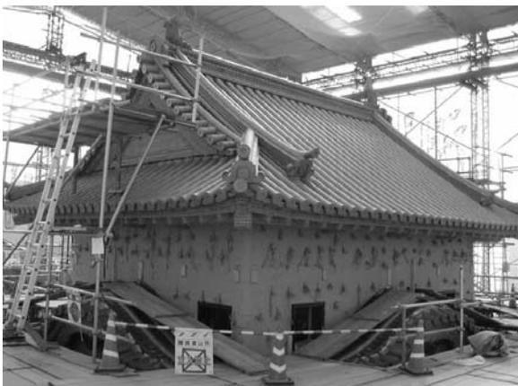
写真—12 天守4層屋根葺完了
