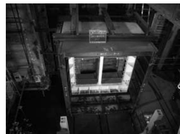
写真一4 発進立坑状況 (刃口部と鋼殻1R目)
