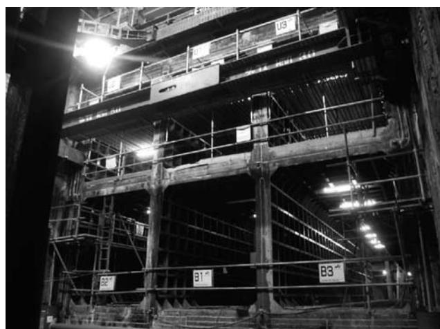
写真一5 掘削完了状況(大阪府内鉄道工事)
