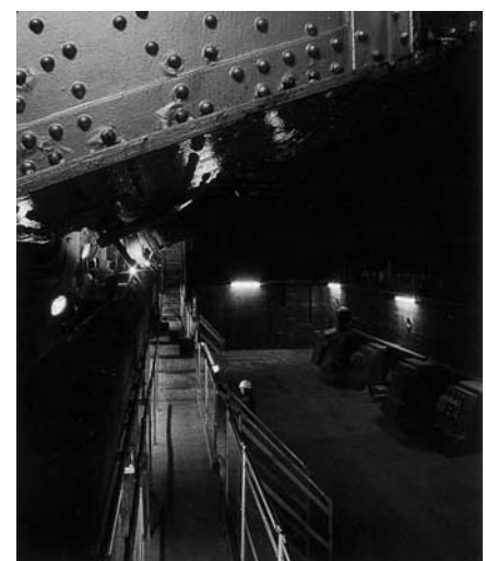
写真三 橋脚内スペース 橋桁があがると、左上から桁の端部が下りてきて、右側のストッパーのところで止まる。
