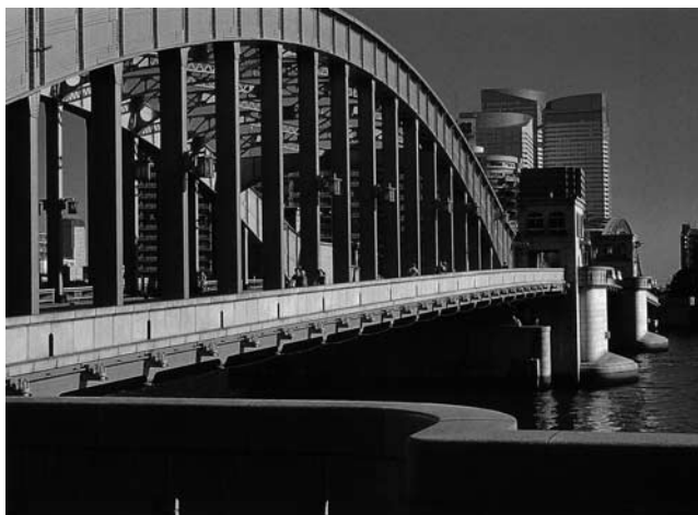
写真—1 橋詰からみる勝鬨橋（下流側）。橋を渡ると、月島・晴海へと続く。*掲載写真は、加藤豊『閉じられたままの勝鬨橋』より。
