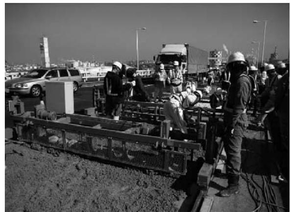
写真-1 SFRC 打設状況
