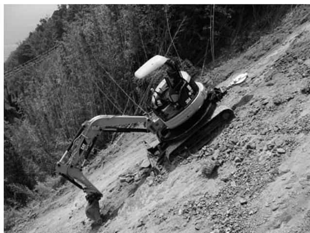
写真-1 掘削・整形作業状況
