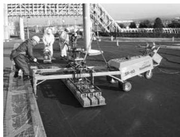
写真二 専用路面ヒータ SR60 による施工状況
