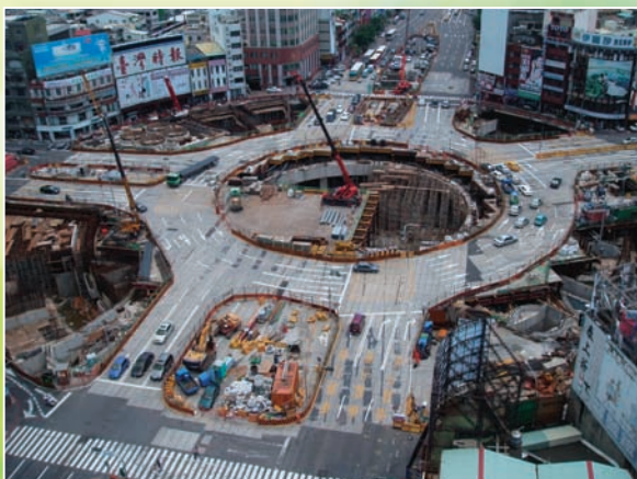
⇧ 2. 同 円形駅部構築施工状況
