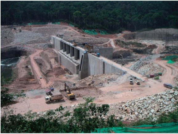
⇧8. ラオスナムツン2 発電所工事 ナカイダム右岸上流より
