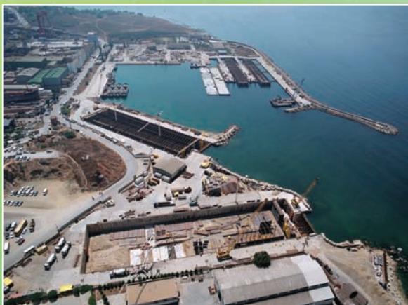
⇧ 6. トルコボスポラス海峡トンネル工事 函体製作ヤード
