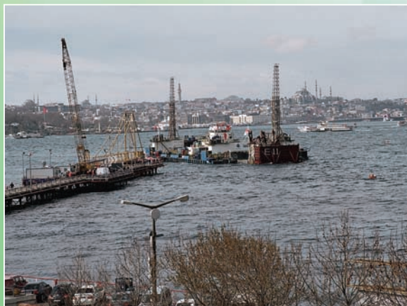
⇧ 7. 同 沈埋函沈設作業
