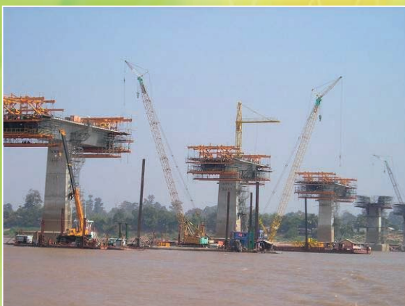
⇧ 4. タイ～ラオス間 第2フレンドシップ橋工事
