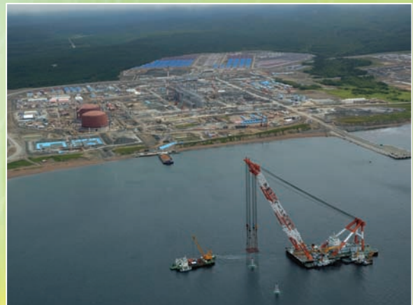
⇧11. 同 3,000T 起重機船によるケーソン据付
