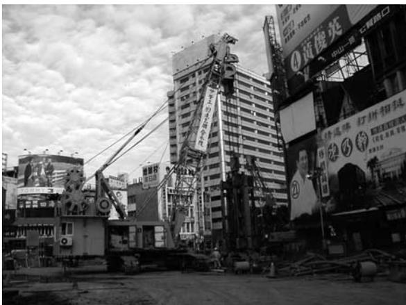
写真-2 円形連続壁 EMX 掘削機
