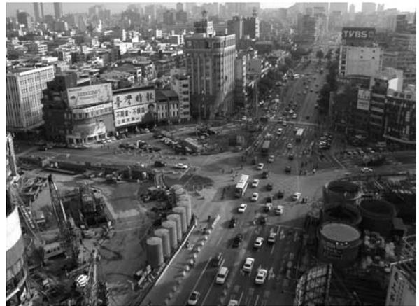
写真-3 円形連続壁施工状況
