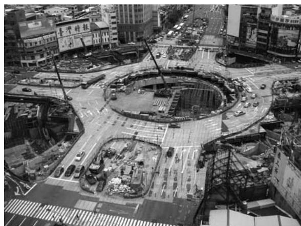
写真—7 円形駅部構築施工状況
