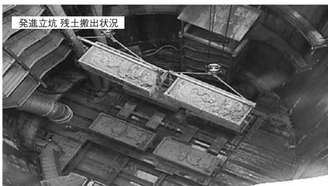
写真一五 掘削土砂搬出状況 (発進立坑)
