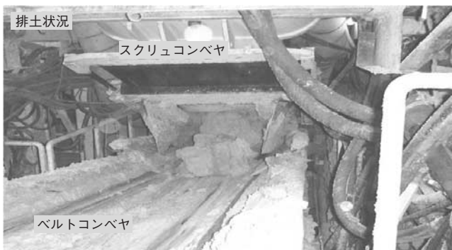
写真一三 掘削土砂搬出状況 1 (シールド機)
