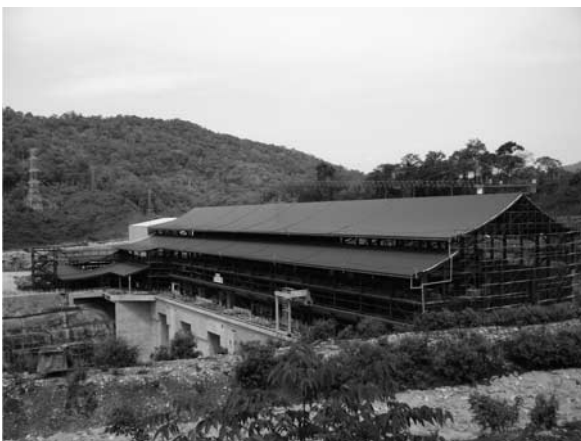
写真-2 CW2 工区 発電所建設工事
