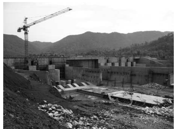
写真-4 CW3 工区 調整堰 (下流右岸より)
