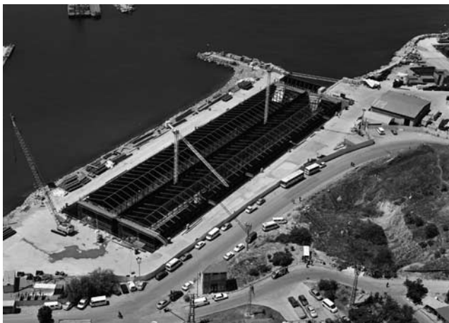
写真一 仮設ドライドックでの函体構築
