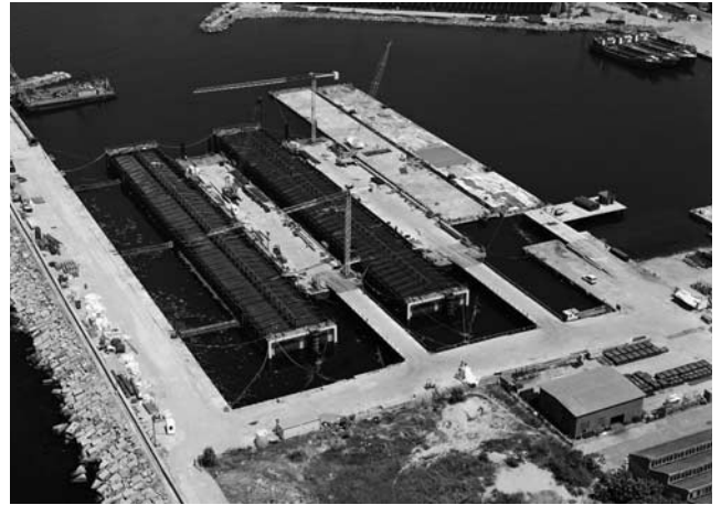
写真二 洋上係留設備での函体構築
