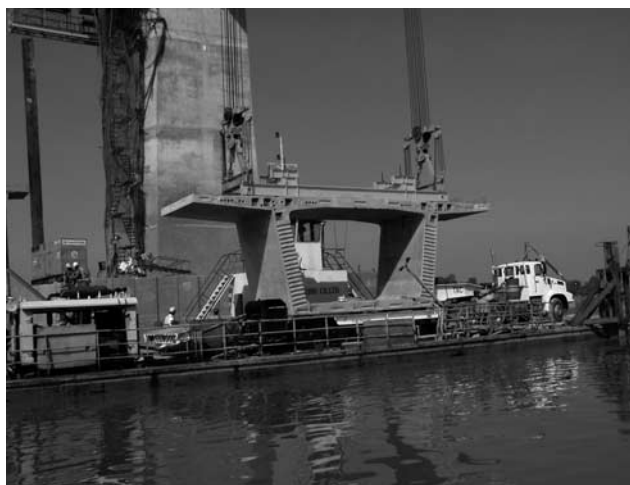
写真-5 セグメント運搬状況
