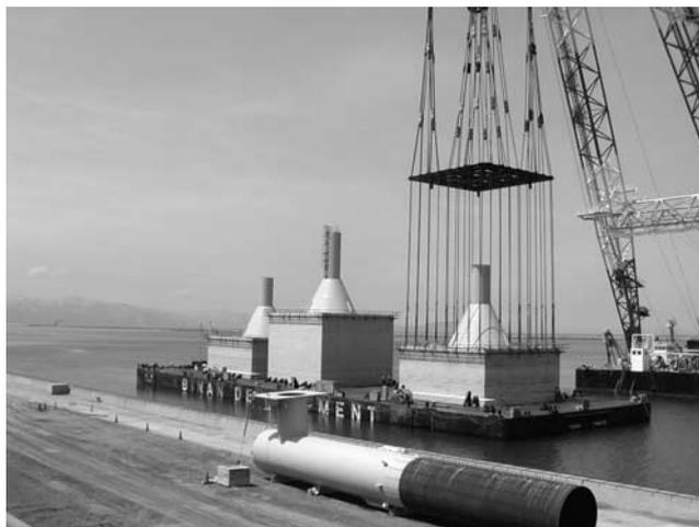
写真—4 3,000T起重機船によるケーソンの積込
