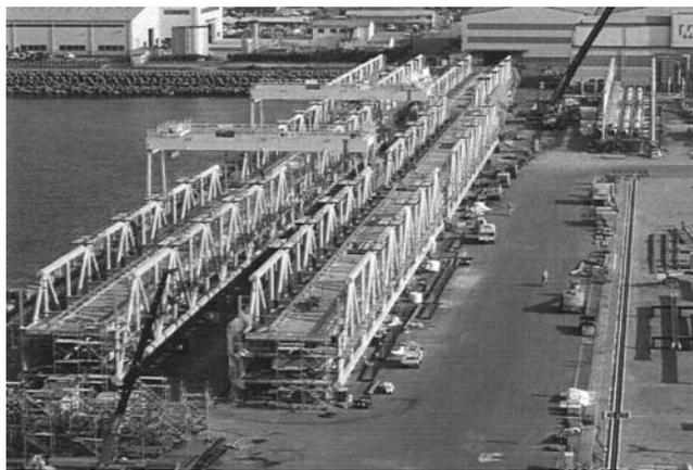
写真—3 80m<sup>2</sup> 階建て連絡橋の製作
