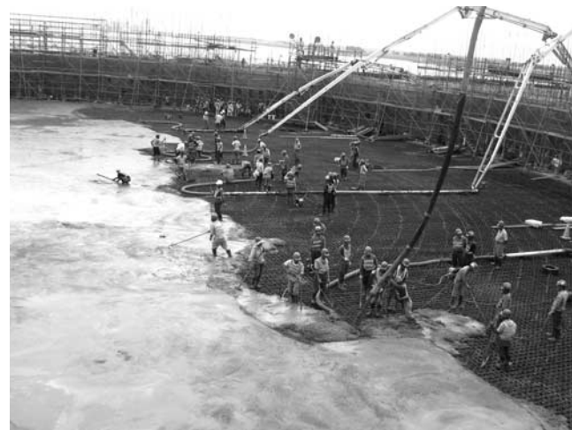
写真—3 基礎版コンクリート打設
