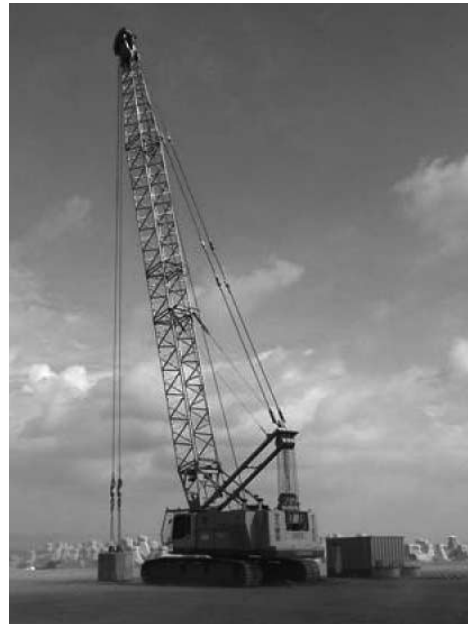
写真一1 動圧密工法 (1)
