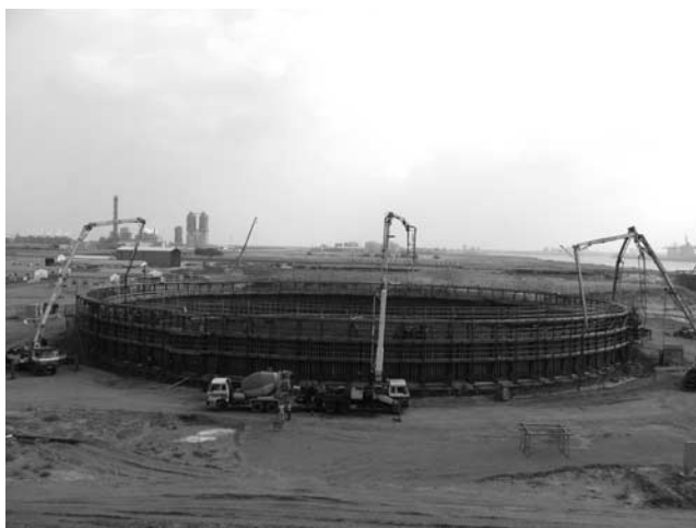
写真-4 PC防液堤コンクリート打設
