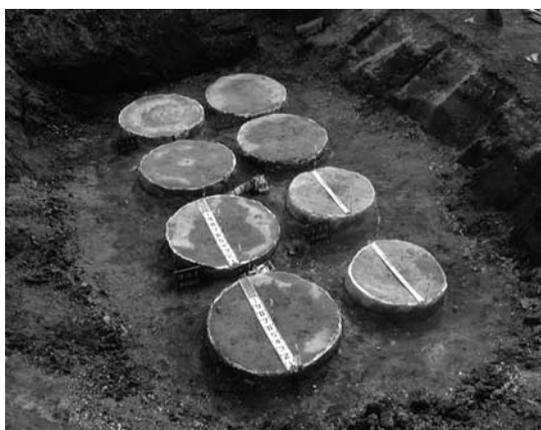
写真—4 大口径施工（手前：φ1300 mm）の改良杭頭
