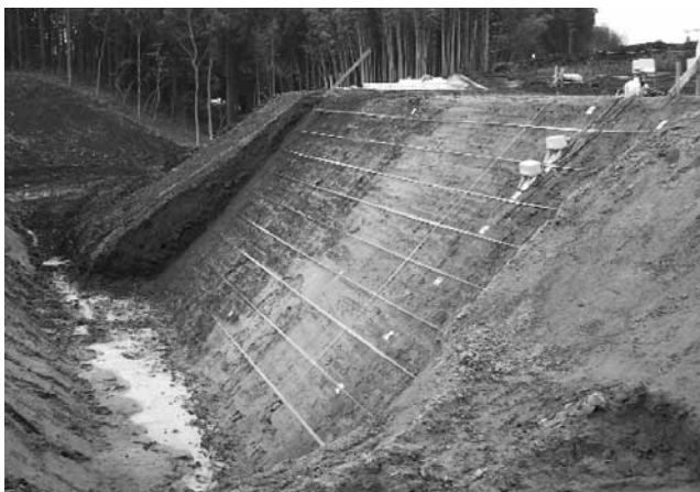
写真—2 実物大規模実験に使用した試験盛土
