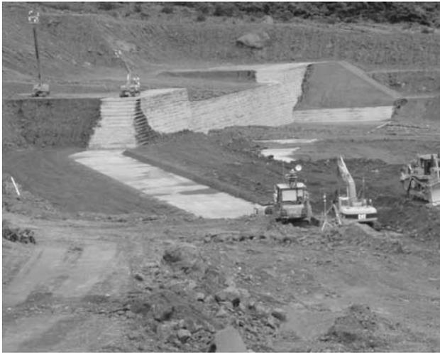
写真一四 土砂型枠無人化施工状況
