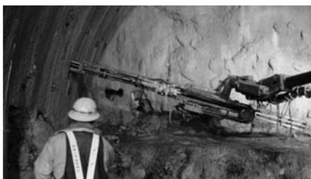
写真一 側壁にスロットを形成している状況
