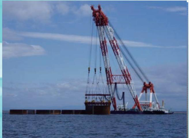
⇨鋼板セル工法 セル打設状況
