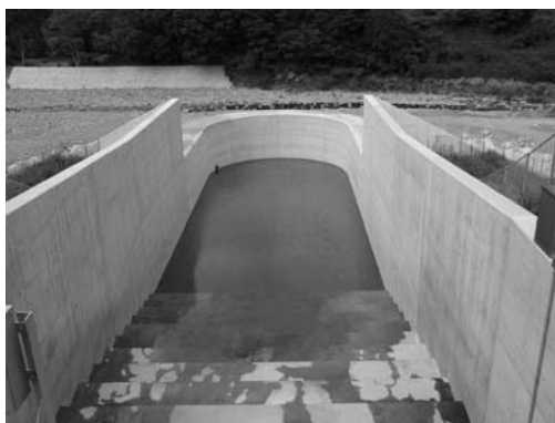
三峰川バイパス出口の状況 (8月17日 放流後約1ヶ月)
