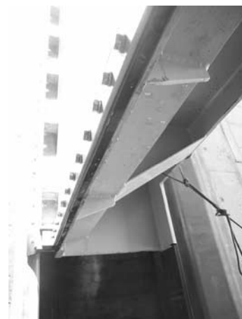
バイパス主ゲートの状況 (8月20日 放流後約1ヶ月)
