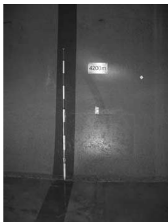
三峰川バイパス内部の状況 (7月20日 放流終了直後)
