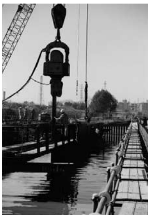
写真—2 鋼矢板一次打設
