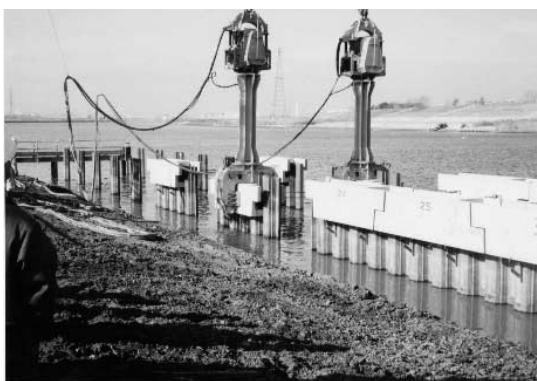
写真—7 後行ユニット打設
