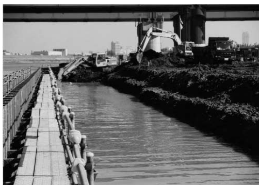
写真—1 先行水中掘削
