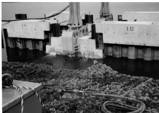
写真—6 先行ユニット打設
