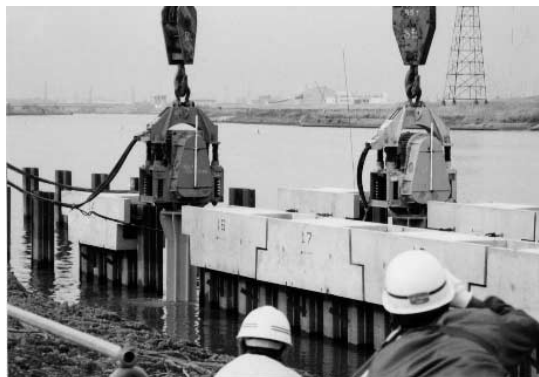
写真一 9 ユニット打設高さ管理状況
