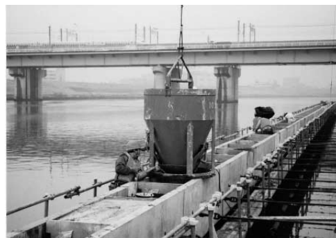
写真—4 中詰めコンクリート打設
