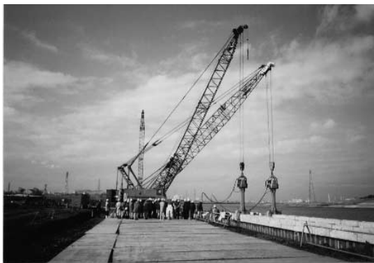
写真—5 ユニット打設（全景）
