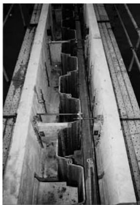
写真—3 PCB 取付
