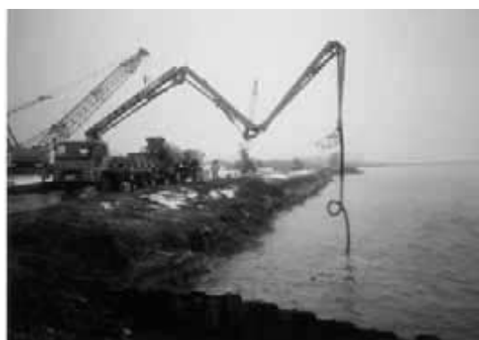
写真—8 接続部コンクリート打設（水中）
