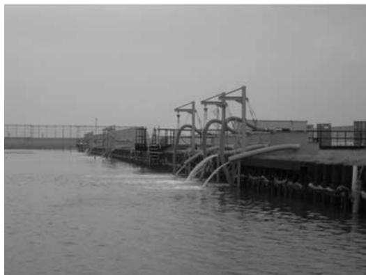
写真—9 負圧載荷状況(真空ポンプ稼働)
