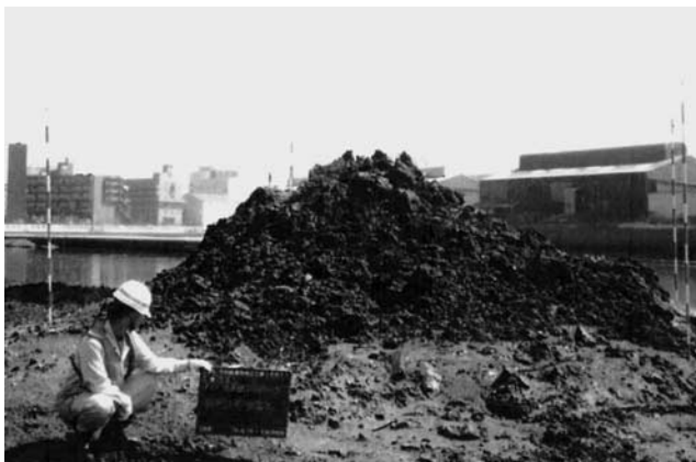
写真—4 干潟土砂仮置き状況
