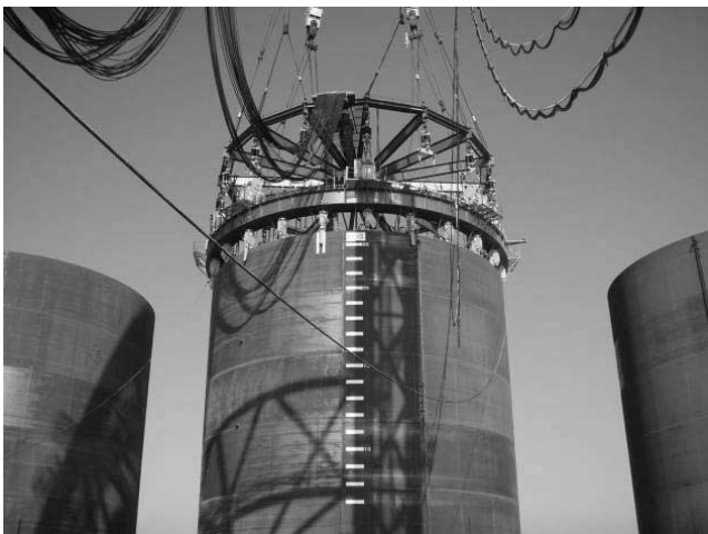
写真-3 チャッキング作業状況
