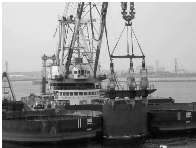
写真—7 アーク打設状況
