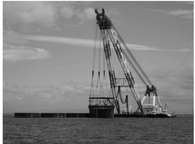
写真-4 セル打設状況
