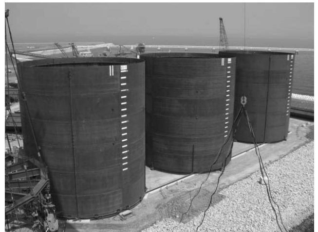
写真-2 セル組立完了 (φ22m × H24.1m)
