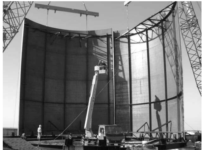
写真-1 セル組立状況
