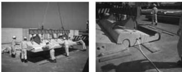
写真—1 ブロック群組み立て状況
