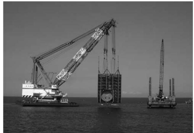
写真-2 J管モジュール沈設
