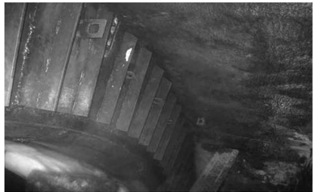
写真-8 止水鉄板取付け状況
