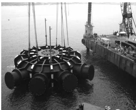
写真—4 マルチノズル放水口設置状況
