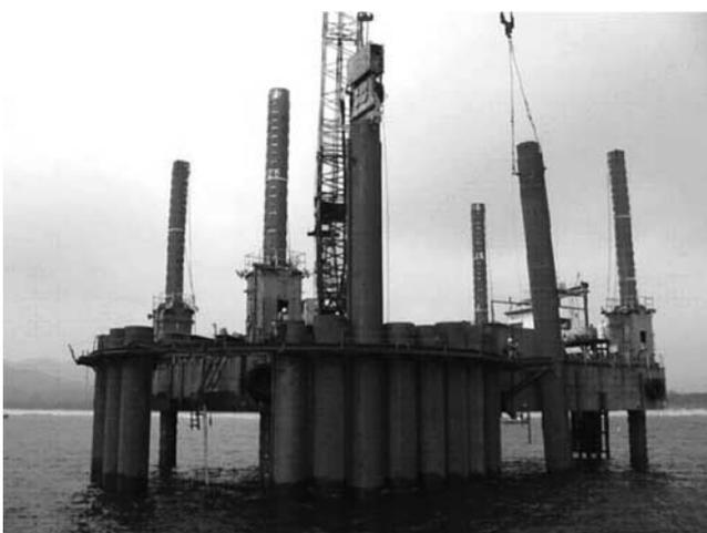
写真-1 鋼管矢板打設（井筒工法）
