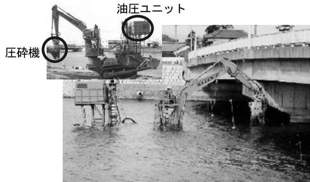
写真一 15 圧砕機による取り壊し状況
