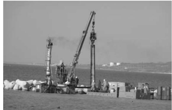
写真一 14 クレーン装置を使った杭打ち状況
