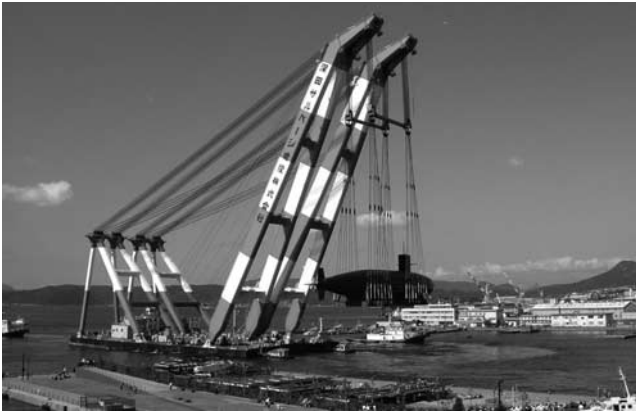
写真—5 潜水艦吊運搬・起重機船係留
