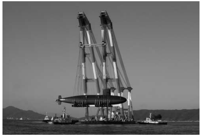
写真-4 潜水艦吊運搬
