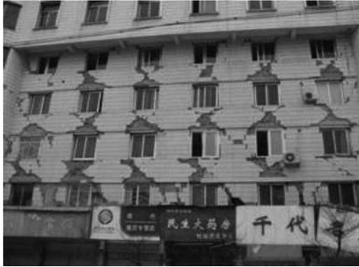
写真—3 建物壁のせん断破壊 (綿竹市)
