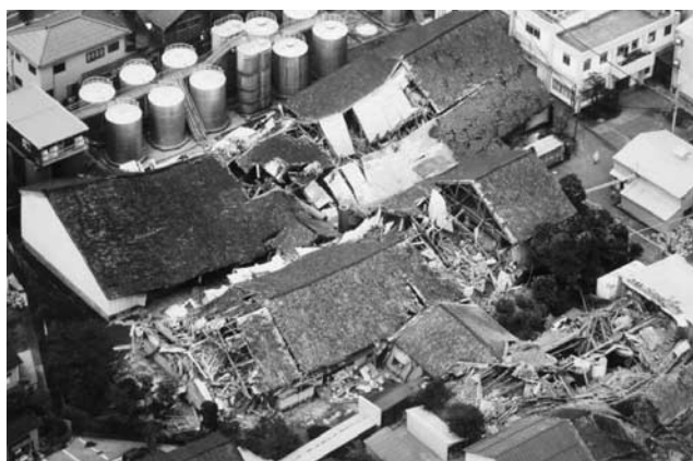
写真—3 崩壊した蔵作り（原酒造&朝日新聞社提供）
