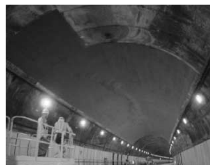
写真-17 炭素繊維による補強状況
