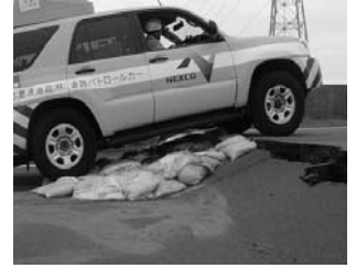
写真六 備蓄土のうを用いての緊急点検
