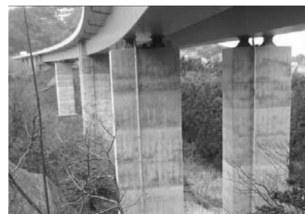
写真-14 耐震補強状況
