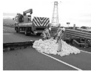
写真五 段差の復旧状況 (吉井川橋 A2 橋台上り線)
