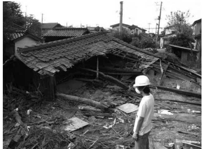
写真—10 作業終了時の倉庫 B
