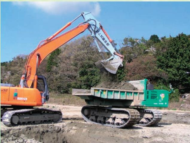
⇧ バケット式解砕機による初期固化土の解砕状況
