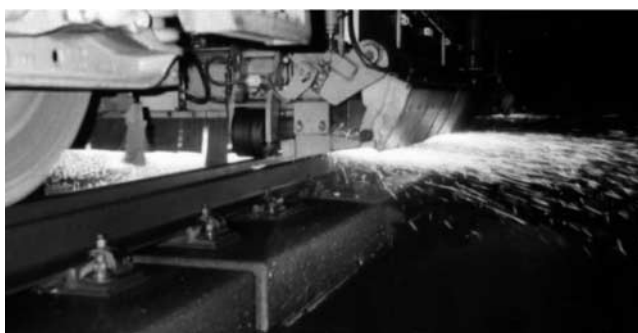
図—8 レール削正車によるレール削正の様子
