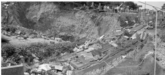
写真—1 陥没被害例（地下碎石場跡）
